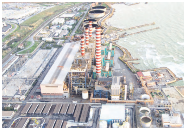
La centrale termoelettrica a carbone pulito di Enel a Torrevaldaliga è dotata di sistemi di controllo e apparecchiature elettriche di ABB che hanno permesso di portare il grado di efficienza dal 39 al 45%
