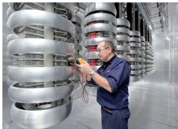
Un ingegnere ABB testa le valvole HVDC Light durante l'installazione
