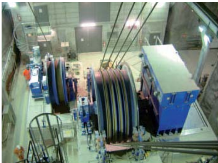
Antriebe für die zwei Förderkörbe, Schachtanlage Sedrun
