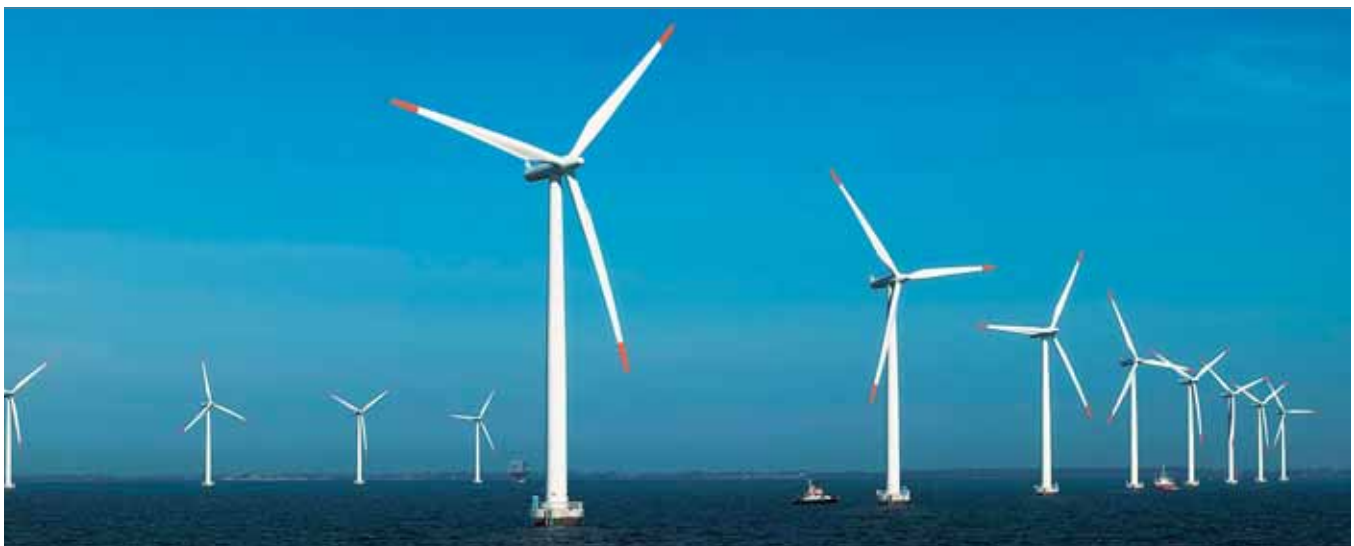
I Der Windpark Nysted umfasst 72 Anlagen mit einer maximalen Leistung von je 2,3 MW.
