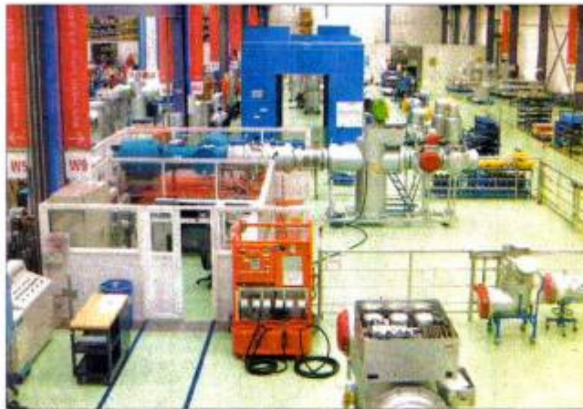
厦门 ABB 高压开关有限公司车间。
