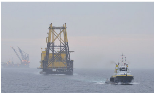
ABB dodala infrastrukturu k připojení nejdlejší větrné elektrárny na světě, 130 km od německého pobřeží. Odhaduje se, že předejde vytvoření 1,5 mil. tun CO 2 ročně tím, že nahradí energii z fosilních paliv.
