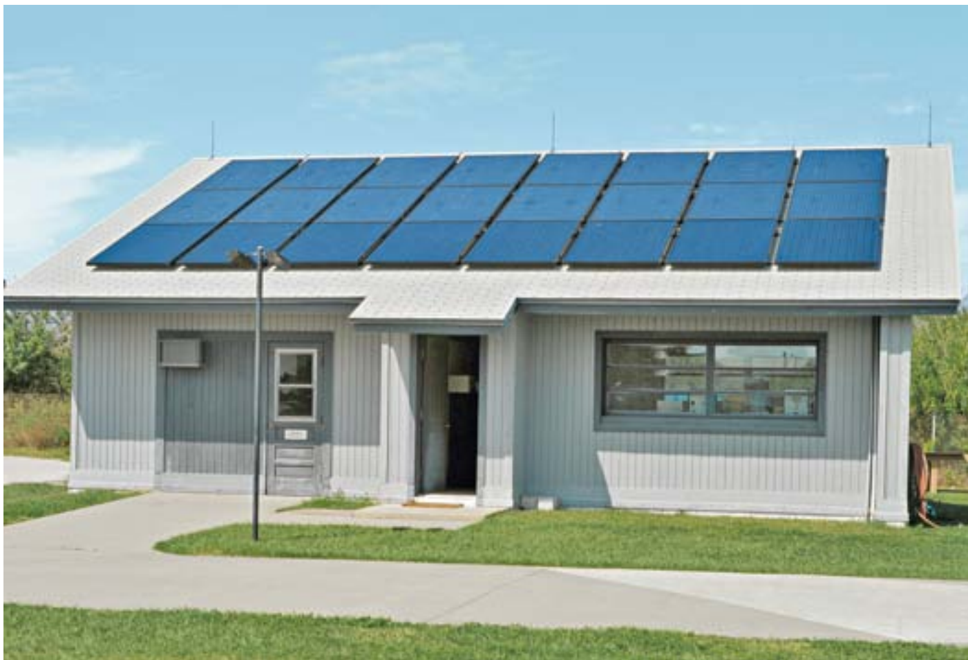
Immer mehr Hausbesitzer nutzen Photovoltaikanlagen zur Solarstromerzeugung und speisen Energie in das Stromnetz ein.
