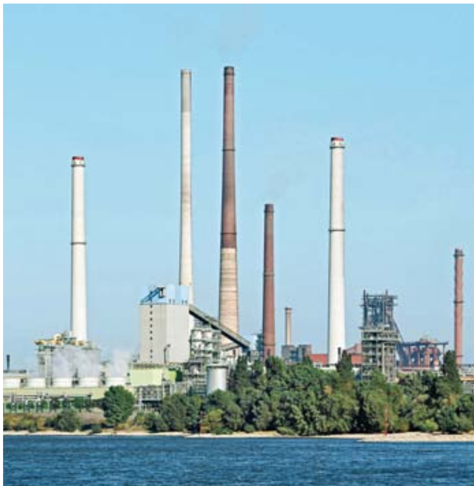
In der Kokerei von ThyssenKrupp in Duisburg-Schweglern ist täglich ein ABB-Mitarbeiter präsent.
