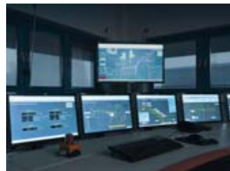
Das Titelbild zeigt das Leitsystem der Bekohlungsanlage eines Kraftwerks. Das Leitsystem bildet die Prozesse der Anlage ab.
