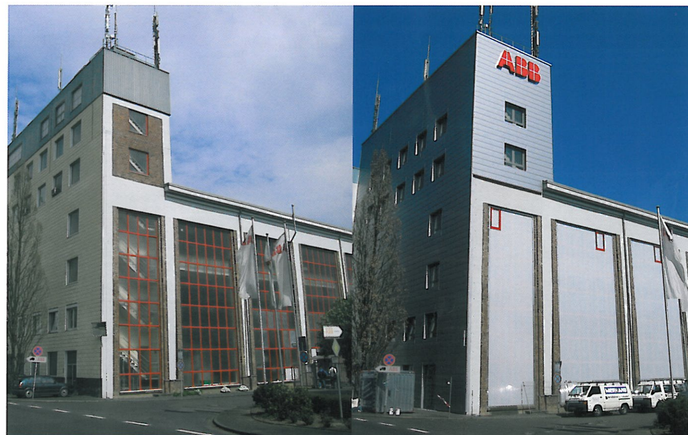
Abb. 2 + 3: Bad Honnef – vor und nach Sanierung der Halle C
