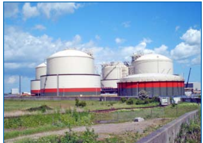
National Grid LNG storage tanks
