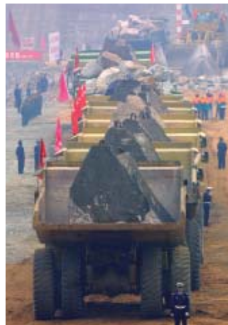
どこまでもビッグスケールな工事現場の光景。2002 年 11 月 4 日には、えん堤の最終的な堰き止め工事を行うため、巨大な岩石を積んだ超特大トラックが長い列を作りました (2002 年 11 月 4 日)
