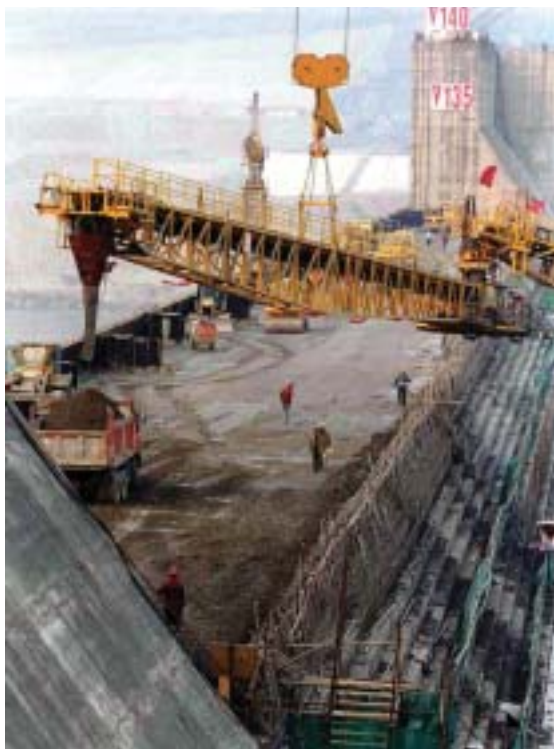
洪水吐（放流口）の幅は 400 m。落差は 80 m 近くあり、ナイアガラ滝（落差 51 m）に勝るとも劣らない壮大な光景が広がることでしょう。2003 年 3 月の時点で、えん堤は 140 m の高さまで工事が進んでいます。
