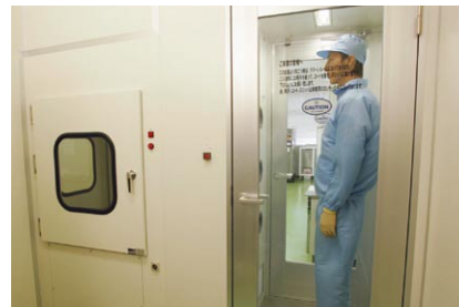
製造する製品の品質確保に欠かせないクリーンルームを従来よりもスケールアップしました。人間はもとより機材や材料もエアシャワーを浴びてから入室
