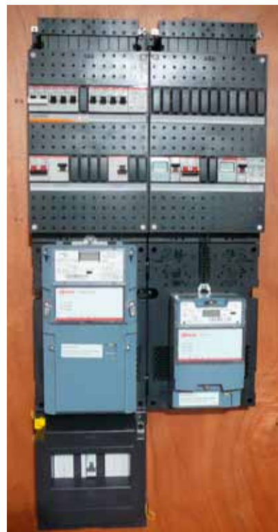
Proefopstelling bij GSU (Eneco) te Houten waar een micro-wkk en zonnepanelen zijn aangesloten op een ABB Hafonorm installatiekast.
