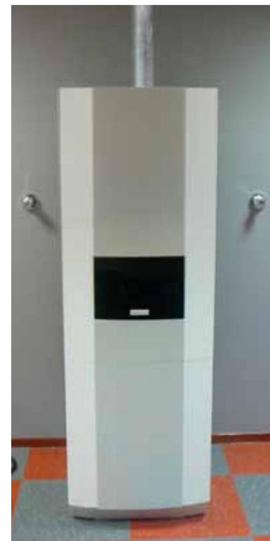
Proefopstelling bij GSU (Eneco) te Houten waar een micro-wkk en zonnepanelen zijn aangesloten op een ABB Hafonorm installatiekast.
