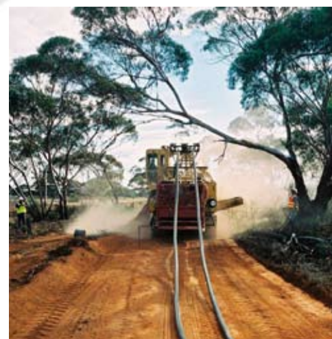
Bij het Murraylink project in Australië is een zeer succesvolle en eenvoudige methode toegepast waarbij gebruik gemaakt wordt van aangepast materieel uit de glasvezelindustrie.
