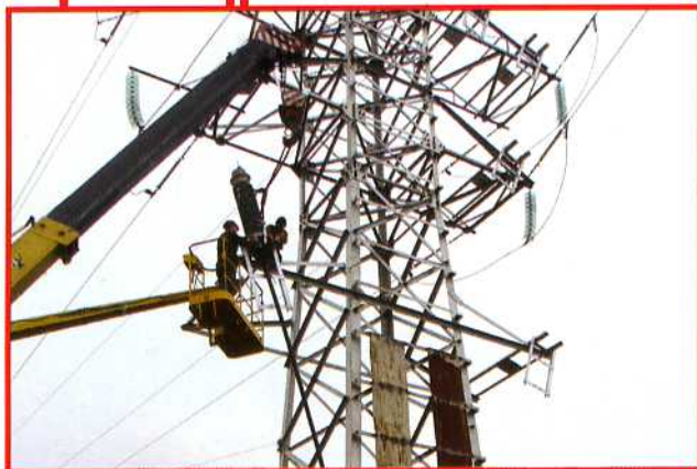
Установка кабельной муфты 110 кВ на опоре, п/ст "Кремлевская", г. Казань
