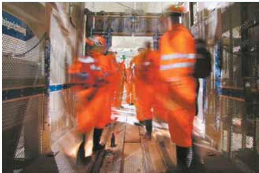
Подъемная система в Седране. ©AlpTransit Gotthard Ltd.
