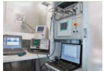
1в Операторная мобильной испытательной системы.
