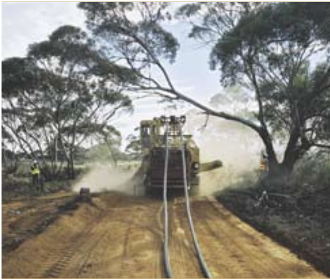
5 Строительство линии HVDC Light® «Murraylink» (Австралия).
