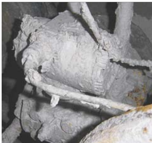
1 Дифференциальный датчик давления в жестких условиях: техническое обслуживание затруднено.
