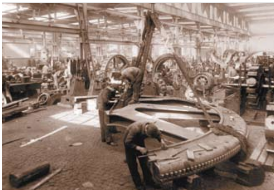
Сборка генератора в Бадене, Швейцария, 1895 г.
