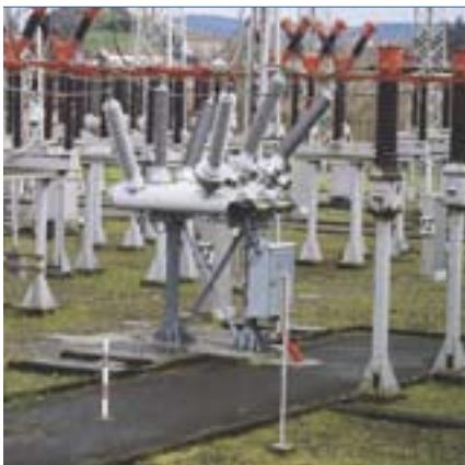
5 Модуль PASS M0 с приводом Motordrive
