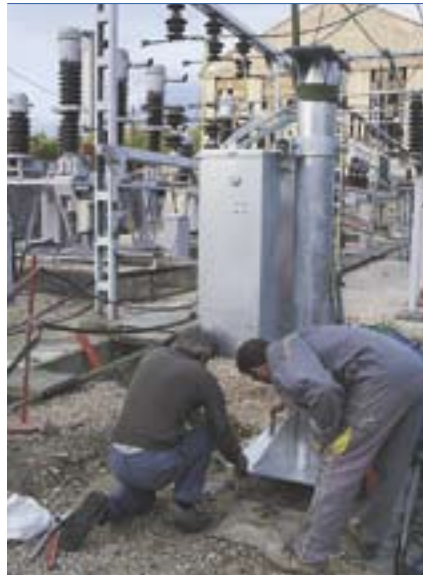
8 Монтаж опорной конструкции
